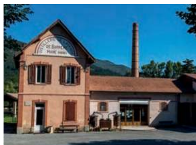
Distillerie de Barrême
