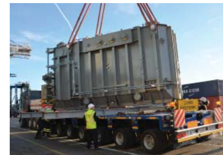
Arrivée du 1 er transformateur électrique (14 janvier 2015)
