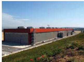
Bâtiment des bobines poloïdales (2012)
