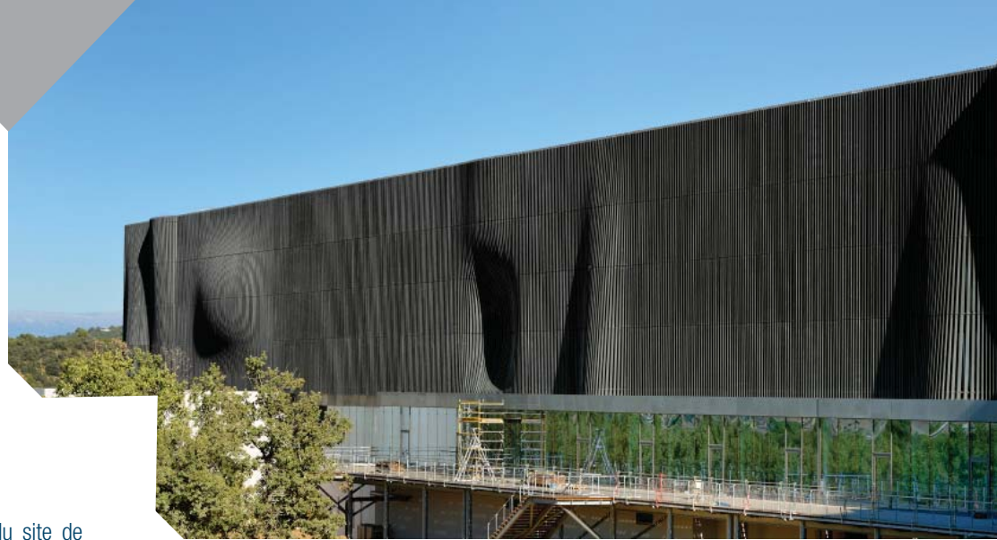
Façade du siège ITER inauguré officiellement le 17 janvier 2013. Le siège ITER accueille les équipes de l'équipe internationale.
