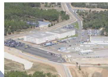
Près de 6 800 m 2 de bureaux modulaires mis à la disposition d'ITER de 2007 à 2009
