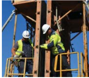
Chantier-école des coffreurs-bancheurs
